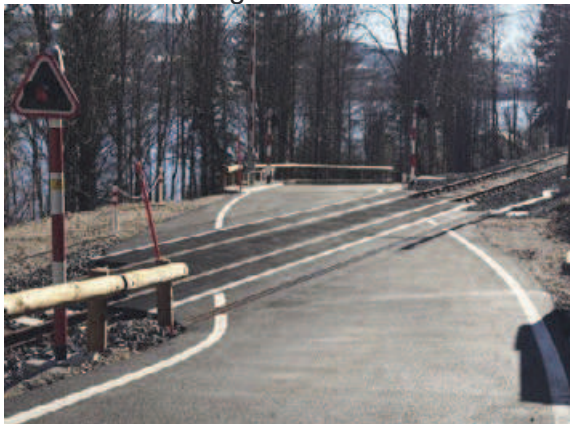
Passage à niveau
