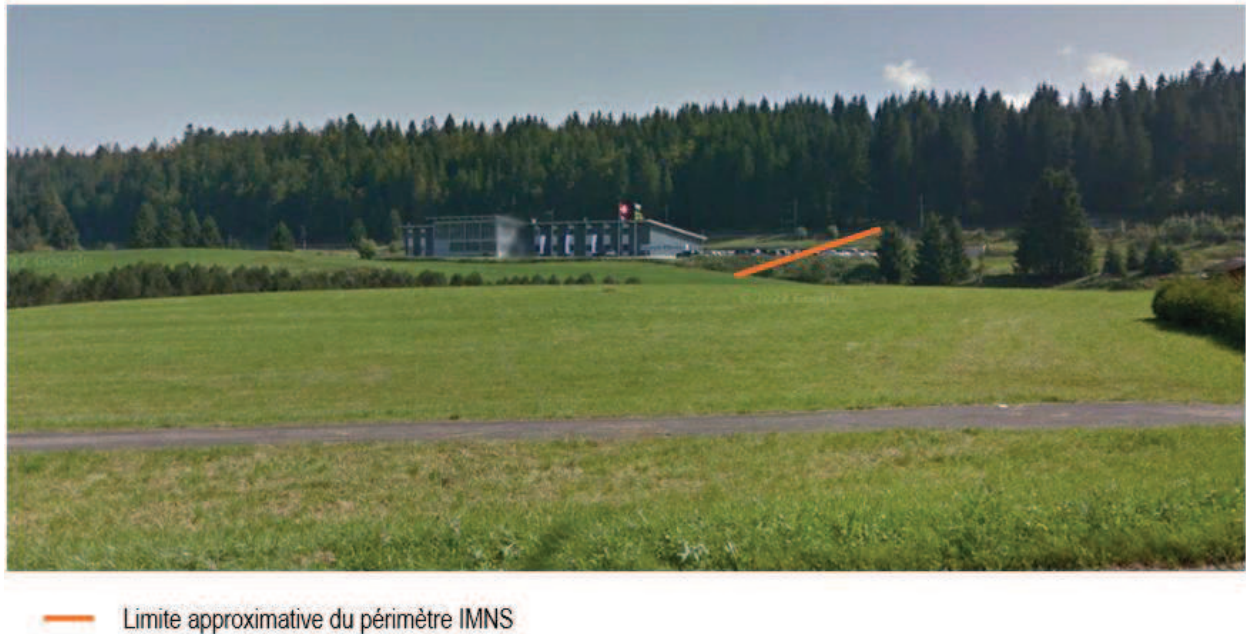
Fig. 7. Vue du bâtiment industriel depuis l'entrée Nord du Village du Lieu
