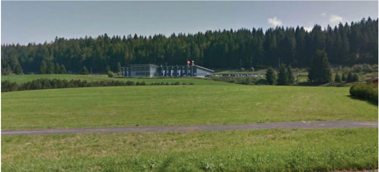
Fig. 5. Vue du bâtiment industriel depuis l'entrée Nord du Village du Lieu
