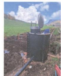
Puits du Pont : les travaux de mise en conformité ont commencé, soit l'échange des 2 pompes avec leur variateur de vitesse. Préparation du câblage pour le futur traitement UV et le turbidimètre. Nous avons fait une demande pour avoir une concession pour le pompage car jusqu'à présent il n'y en avait pas !
